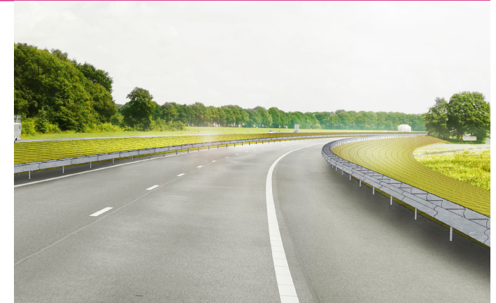
Panelen op flauw talud boogstraat A37 (Zonneroute A37)
