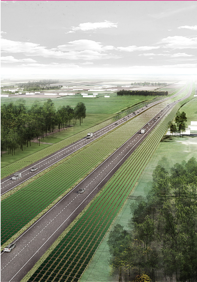
Energiebermen aaneengesloten lijn van panelen (Zonneroute A37)
