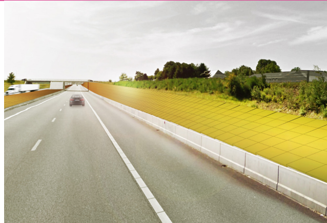
Energieberm loopt op richting viaduct (Zonneroute A37)
